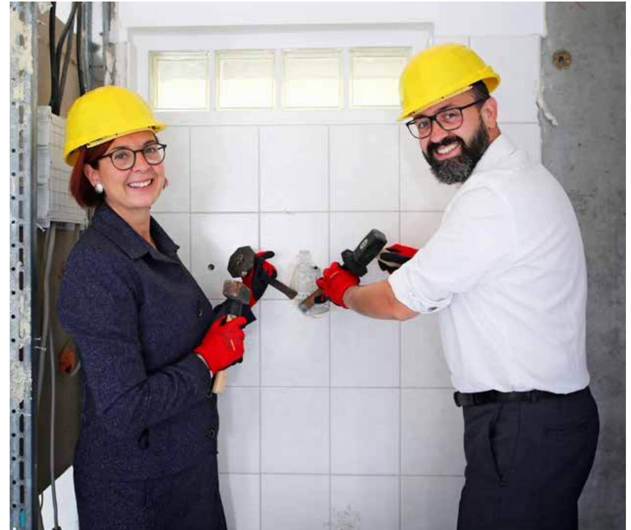
Dr. Andrea Diekhof, Geschäftsführerin des Studentenwerkes Leipzig, und Sebastian Gemkow, Sächsischer Wissenschaftsminister, auf der Baustelle Studentenwohnheim Mainzer Straße 2a
