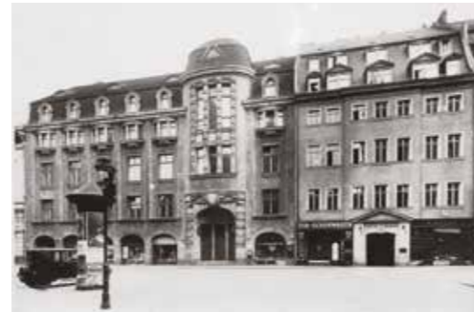
➤ Blick auf das Gebäude Handelshochschule in der Ritterstraße 8–10.
