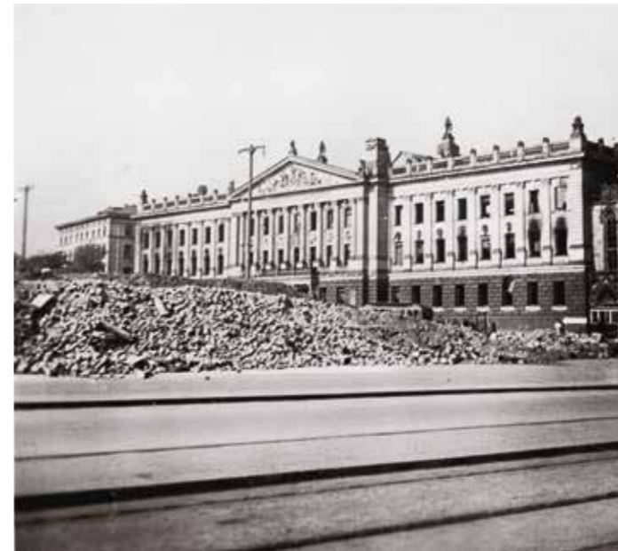
Kriegsschäden am Augusteum, Mai 1944
